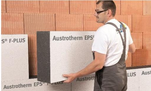
Höchstwärmedämmende Fassadendämmplatte aus expandiertem Polystyrolhartschaumstoff mit **Protect-Beschichtung**
