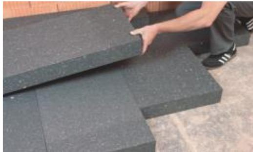
Hoch druckbelastbare, höchstwärmedämmende Dämmplatte aus expandiertem Polystyrolhartschaumstoff
