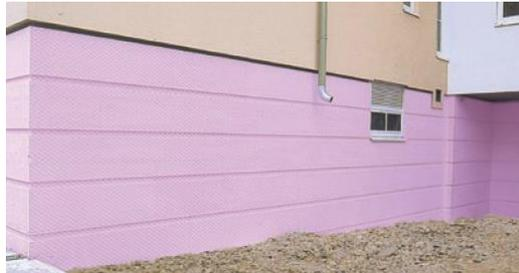
Druckfeste Wärmedämmplatte aus extrudiertem Polystyrolhartschaum mit **geprägter Oberfläche** und **gerader Kante**
