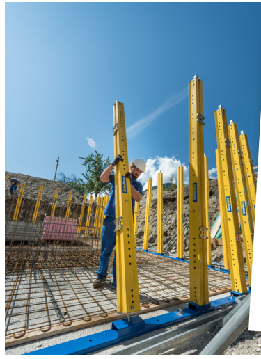
Errichten der Stützkonstruktion
