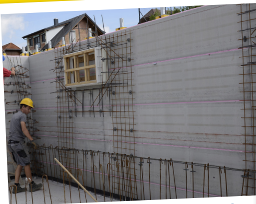
Aussparungen und Bewehrung der Wand
