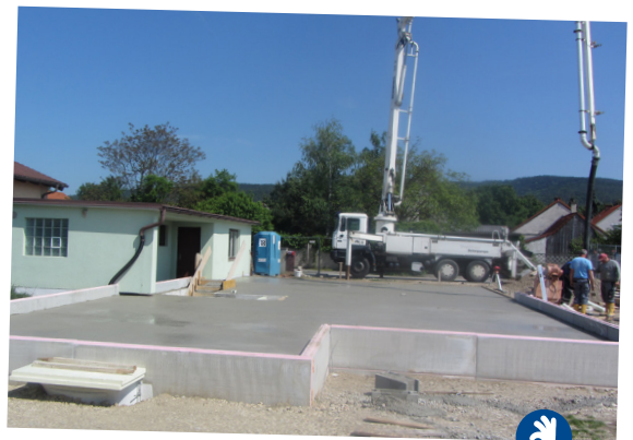
Betonage der Wände und Decken
