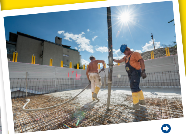
Betonage der Bodenplatte
