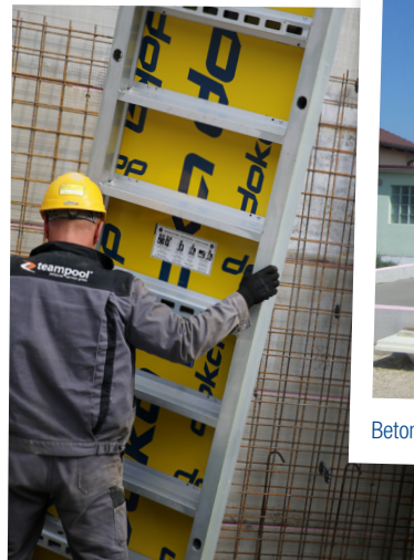
Schließen der Schalung
