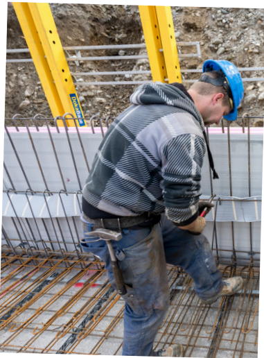
Einbau von Bewehrung und Installation
