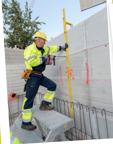
Bohrung der Ankerlöcher
