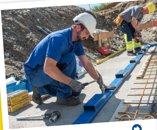
Montage der Bodenschienen
