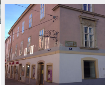
Wenige Profile waren noch erhalten, der Rest wurde originalgetreu nachgebaut. Die Seite zur Domgasse hin hat der Eigentümer auf eigene Initiative ergänzt.
