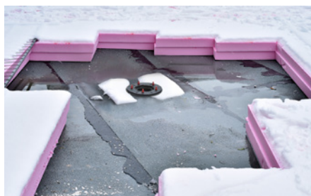
Um notwendige Anschlusshöhen herzustellen beziehungsweise zu vergrößern, wurden die Platten je nach Bereich in unterschiedlichen Dicken verlegt. Im vorderen Bereich sind die Austrotherm Dämmplatten bereits mit einer Kiesschicht belegt.
