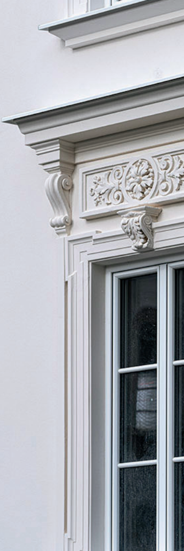
Wenige Profile waren noch erhalten, der Rest wurde originalgetreu nachgebaut. Die Seite zur Domgasse hin hat der Eigentümer auf eigene Initiative ergänzt.
