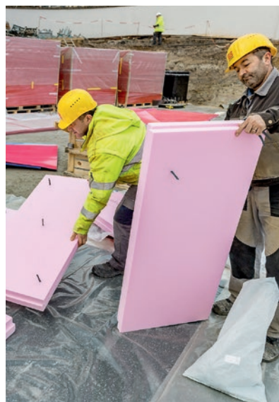
Kunststoffdübel, sogenannte Tannenbäume, werden in die XPS-Dämmstoffplatten getrieben. Die Spitzen, die auf der anderen Seite herausragen, werden später einbetoniert.
