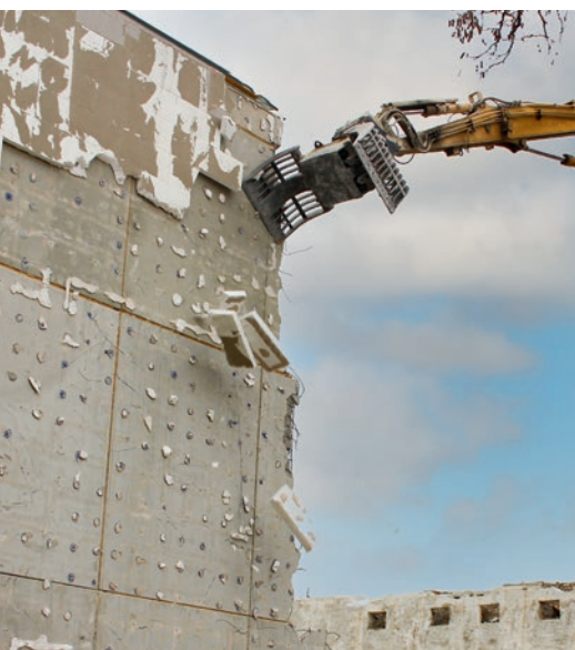
Ein maschineller Rückbau einer EPS-Fassade ist kein Problem mehr.
