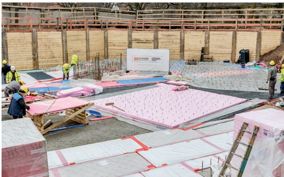
Die zukünftigen Seniorenwohnungen liegen genau über einem bestehenden U-Bahn-Tunnel. Vergleichsberechnungen haben ergeben, dass die U-Bahn-Röhre die Lasten nicht ohne weiteres aufnehmen kann. Die Austrotherm XPS®-Dämmstoffplatten müssen deshalb im Bereich der Tunnelrinne freischwiegend verankert werden.
