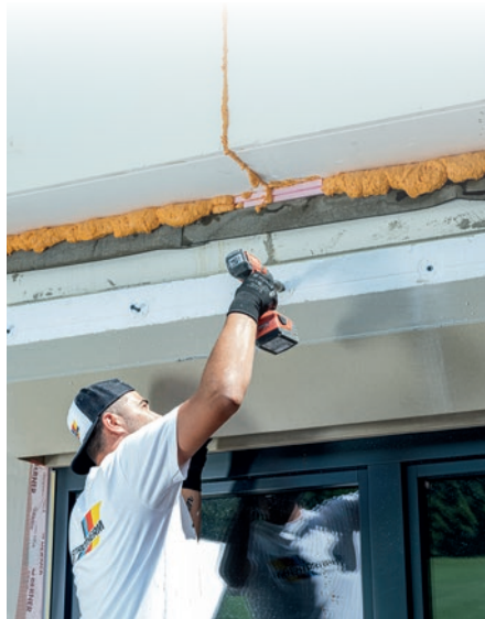
Auch technische Sonderlösungen sind mit Austrotherm Fassadenprofilen möglich. Im Bild zu sehen: ein Architekturelement zur Ausbildung einer Schräglabung inklusive eines Raffstorekastens
