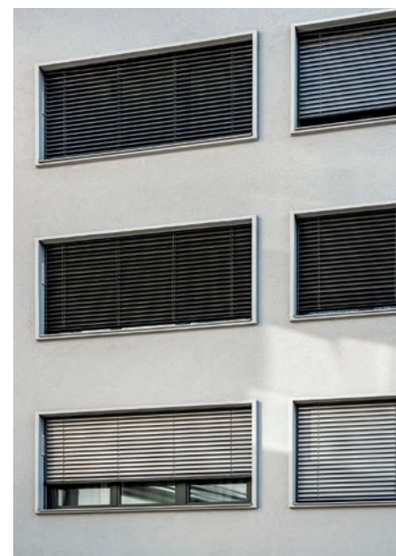
Der Wohnturm erhielt Fensterumrahmungen im „Monitor-Design“.
