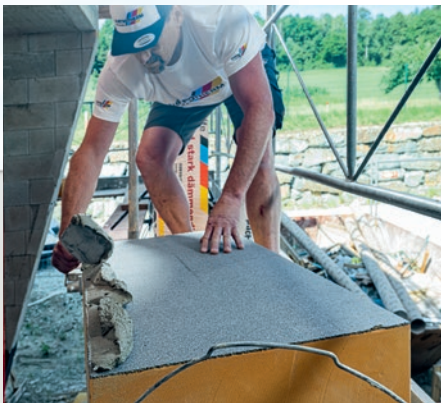
Ganz einfach: Austrotherm Resolution® wird wie jede EPS-Fassadendämmplatte im Rand-Wulst-Verfahren mittels Klebspachtel verarbeitet.
