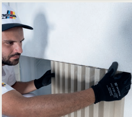
Das Austrotherm Kammprofil wird nach der Endbeschichtung der Fassadenoberfläche montiert.
