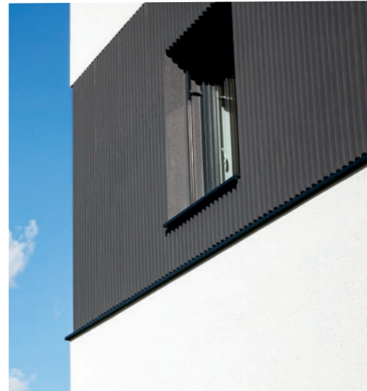
Auch technische Sonderlösungen sind mit Austrotherm Fassadenprofilen möglich. Im Bild zu sehen: ein Architekturelement zur Ausbildung einer Schräglabung inklusive eines Raffstorekastens
