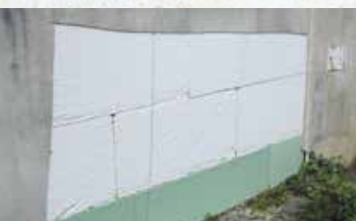
Die gestrippte Fassade ist die Basis für die thermische Sanierung.
