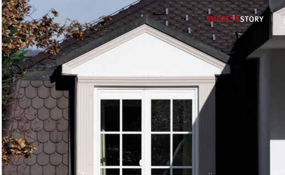
Nachher: Die Fassadenprofile erstrahlen in neuem Glanz.
