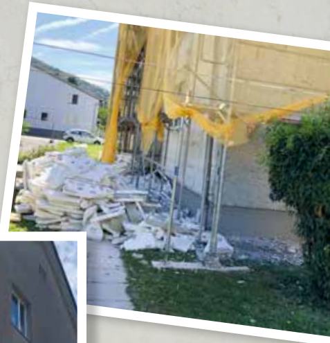
Die bestehende Dämmung muss zur Gänze entfernt werden.
