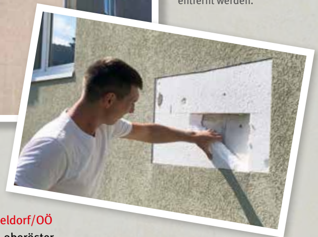
Die bestehende Dämmung muss zur Gänze entfernt werden.
