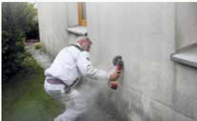
Beim „Strippen“ der Fassade wird der Putz in der Regel mit einem Trennschleifer senkrecht eingeschnitten.
