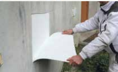
Danach lässt er sich streifenweise in vertikalen Bahnen abziehen.
