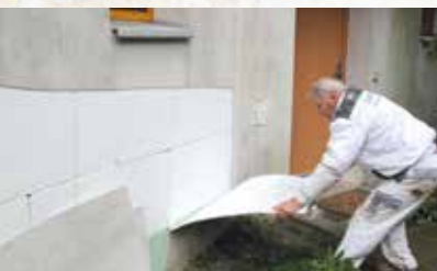
Wichtig für rückstandsfreies „Strippen“ ist ein spitzer Schälwinkel – weniger als 45 Grad – und langsames Abziehen.
