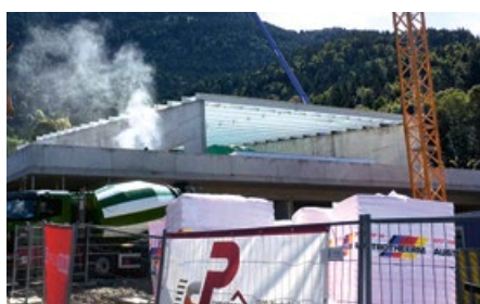
930 Kubikmeter druckfeste Austrotherm XPS® halten Kälte aus dem Boden und von oben wirkungsvoll ab.
