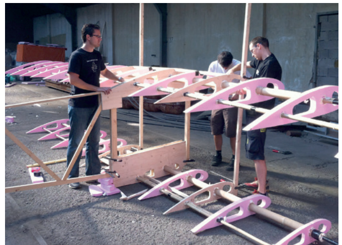
Bau eines Doppeldeckers mit zehn Metern Spannweite aus Austrotherm XPS® für den Red Bull Flugtag am 23. September 2012 in Wien. Mehr dazu auf Seite 11.
