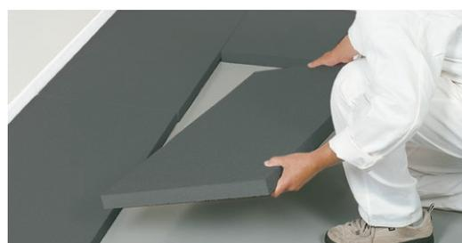
Höchstwärmedämmende Trittschalldämmplatte aus expandiertem Polystyrolhartschaumstoff für Gesamtbelastungen bis 1.000 kg/m<sup>2</sup>.
