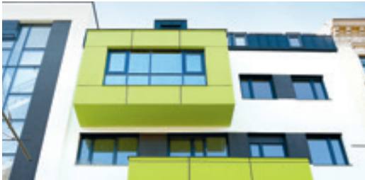
Fassadendämmplatte mit Austrotherm Beschichtungsmasse TOP.
