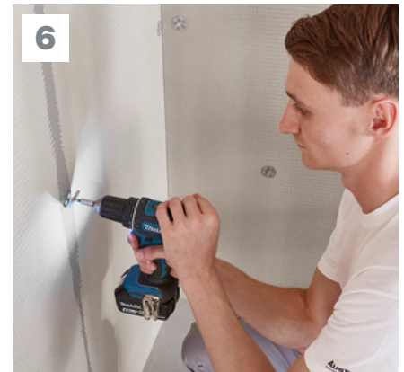
6 Verschrauben der Platten Die Austrotherm UNIPLATTEN mit Schrauben und Dämmstofftellern mittig auf dem Holzständerwerk befestigen. Dämmstoffteller in die Stoßfugen schrauben, es müssen beide flankierenden Bauplatten gehalten werden.
