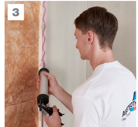
3 Kleber aufbringen Bei geringer Beanspruchung durch Feuchtigkeit werden die Austrotherm UNIPLATTEN mit dem systemgeprüften Dichtstoff untereinander verklebt.
